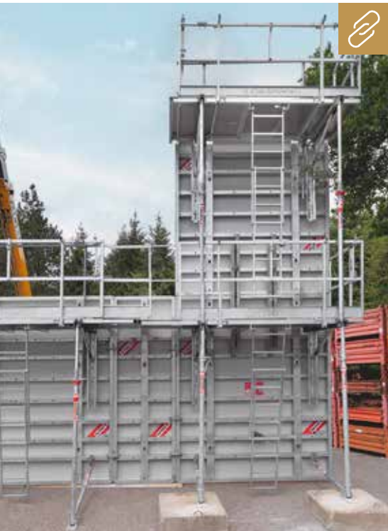
Das MIS-System von Meva verbleibt am Wandschalungselement und ermöglicht so das schnelle Umsetzen und platzsparende Stapeln kompletter Einheiten. Bilder: Meva
