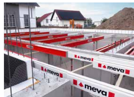
VarioMax ist das neue Unterstützungssystem für Filigrandecken von Meva. Es reduziert den Zeit- und Materialaufwand und vereinfacht die Lagerhaltungen.
