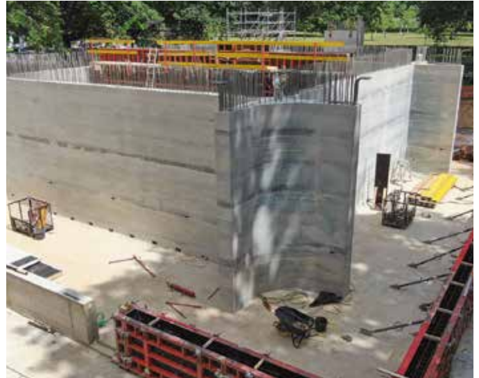
Die alkus Vollkunststoffplatte ist biegesteif, lässt sich jedoch einfach in Form bringen. Damit lassen sich auch Rundungen und Ecken realisieren.
