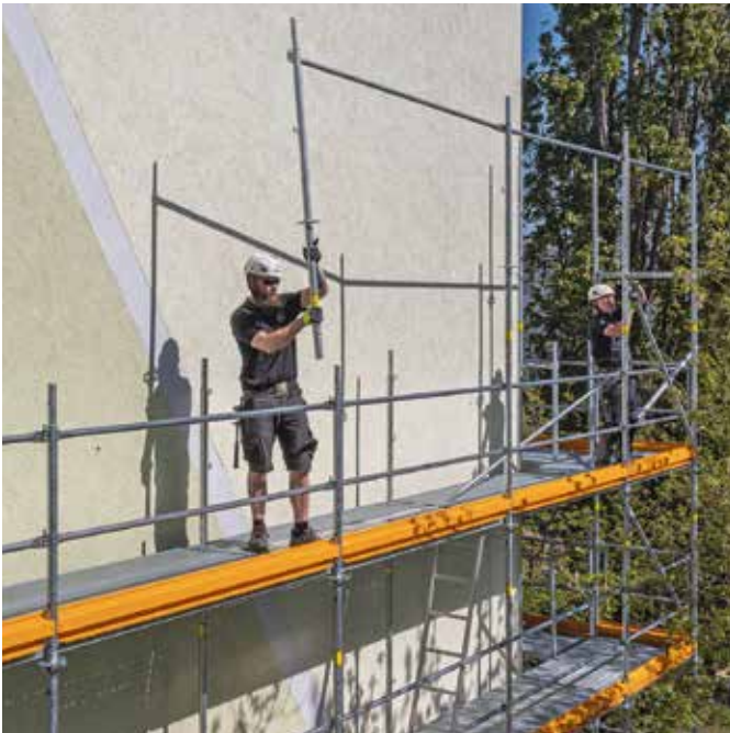
Beim Fassadengerüst wird das Geländer für die nächste Ebene von der unteren, bereits gesicherten Gerüstlage aus montiert.
