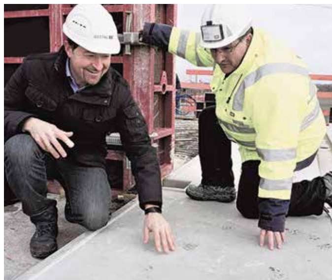
Westag-Fachberater Michael Hörmann (li.), Porr-Polier Peter Ludwig (re.): Die Oberfläche der Fluchtbalkone sollte rutschhemmend sein. Eine spezielle Schalplatte hat das möglich gemacht. Bild: Westag
