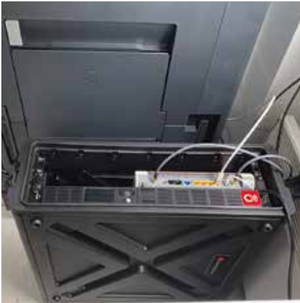
Die kleinsten Anlagen können in Eigenregie montiert werden, die größeren Anlagen werden von Monteuren professionell aufgebaut.
