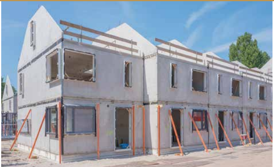
Bei der Vorfertigung erfolgt die Produktion der einzelnen Elemente millimetergenau in einer Fertigungshalle außerhalb der Baustelle – eine Bauweise, die derzeit im Kommen ist. Bild: 123rf
