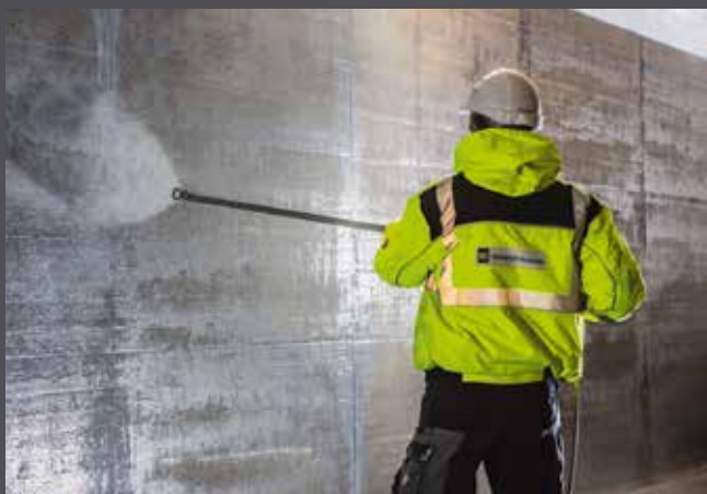
Sikagard-740 W wurde als Bestandteil des Oberflächenschutzsystems in einem Arbeitsgang mittels Airless-Spritzverfahren appliziert. Bild: Sika
