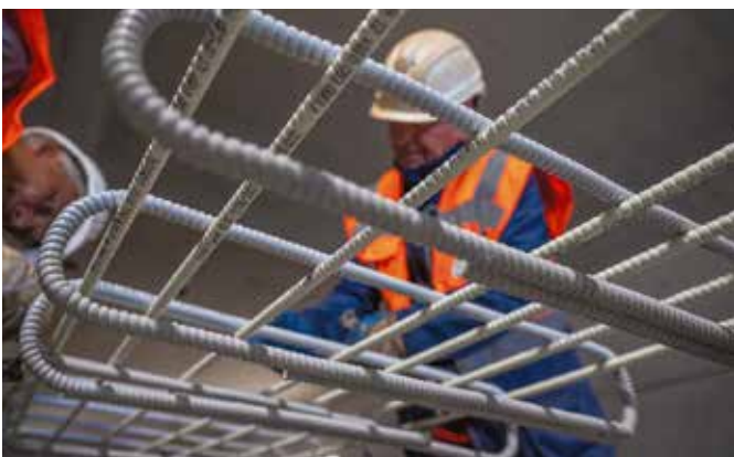
Combar ist wesentlich leichter als Stahl. Das Handling ist dadurch einfacher und für die Monteure weniger belastend.
