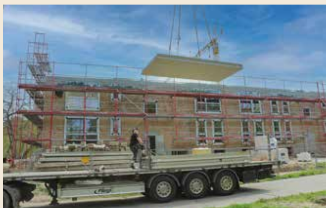
Mit speziellen Betonfertigdecken geht das Aufstocken schnell und einfach. Die vorgefertigten Deckenplatten werden trocken verbaut und sind sofort begehbar. Bild: Dennert
