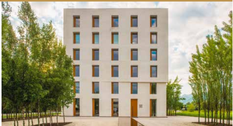
Bürogebäude 2226: Für Temperaturstabilität sorgen ein knapp 76 cm dickes, zweischichtiges Ziegelmauerwerk ohne integrierte Dämmung und ein gering gehaltener Glasanteil. Bild: BE Architekten
