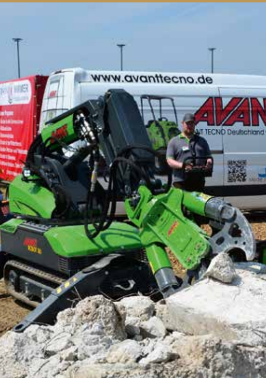
Bauen im Bestand ist das große Thema der Gegenwart und Zukunft. Der Robot 185 von Avant Tecno ist die richtige Maschine für Abbruchaufgaben innerhalb von Gebäuden.
