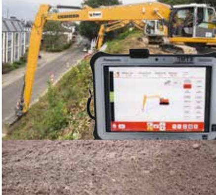
Rund ein Viertel an Bauzeit sparte sich Bauleiter Achim Dimmer, indem er sich zur Abwicklung einer Böschungssanierung das MTS-NAVI und einen Bagger mit Spezialausleger anmietete. Weil die 3D-Baggersteuerung auch Spezialausleger von Baggern exakt abbilden kann, musste Dimmer überdies nur eine Standebene erstellen und konnte sich so das Anlegen von zusätzlichen Wegen sparen. 23
