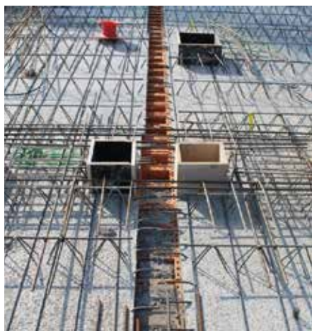
Die Poroton-Planfüllziegel sorgen für höheren Schallschutz zwischen den Wohnungen. Dazu werden sie auf der Baustelle mit Beton verfüllt.
