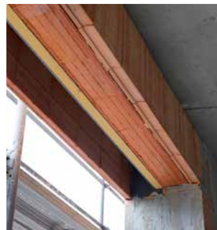
Der mit Perlit gedämmte Jalousienkasten Roka-Lith-Shadow wurde entwickelt, um einen einheitlichen Putzgrund auch im Raffstore-Bereich zu ermöglichen und gleichzeitig die Wärmebrücke zu minimieren.
