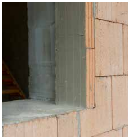
Mit Mörtel geglättet, bildet die Fensterlaibung eine sichere Grundlage für den Fensteranschluss mit den Dichtbändern. Der Fensteranschlag minimiert hier Wärmebrücken.
