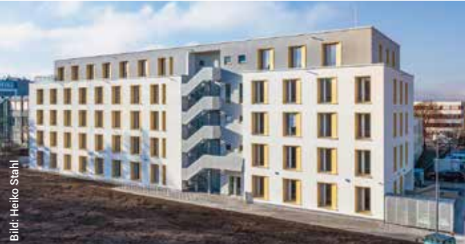
Energetisch autark: Das Bürohaus in München-Gräfelfing hält die Raumtemperatur konstant zwischen 22 und 26 °C – und zwar ohne zusätzliche Heizung oder Klimaanlage. Bilder: Heiko Stahl
