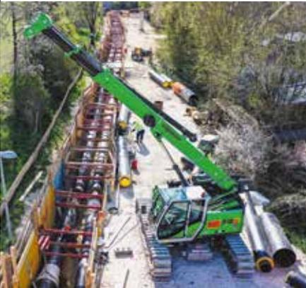
Die Kraftanlagen München GmbH kümmert sich um den weiteren Ausbau des Fernwärmenetzes in Ulm. Um die zuverlässige Versorgung der Gebiete im Nord-Westen der Stadt sicherzustellen, wird eine neue, mehr als 1,2 km lange Rohrleitung verlegt. Genau der richtige Einsatz für den kompakten Raupentelekran von Sennebogen, der die beengten und steilen Platzverhältnisse entlang des Rohrgrabens optimal zu meistern versteht. **54**
