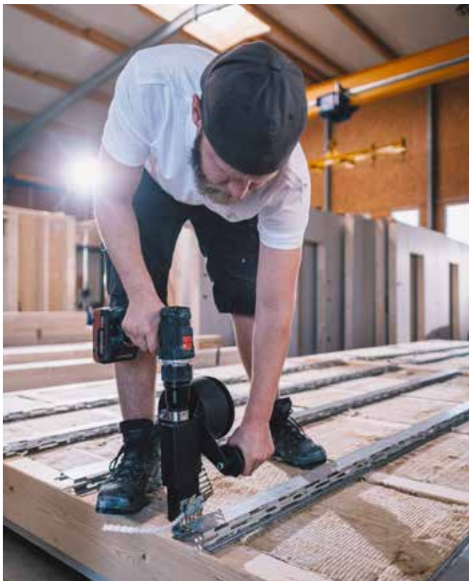
In der Werkstatt des Holzbaubetriebs werden die Wandelemente nahezu komplett montiert. Die ULTIMATE Holzbaudämmung sorgt dabei für hohe Effizienz und Verarbeitungsfreundlichkeit.
