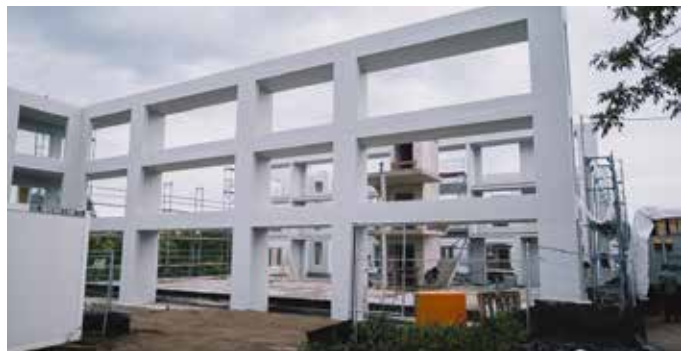
Die freitragenden Balkonfronten sowie die Treppenhäuser und die Fahrstuhlschächte sind die einzigen Bauteile in Massivbauweise.
