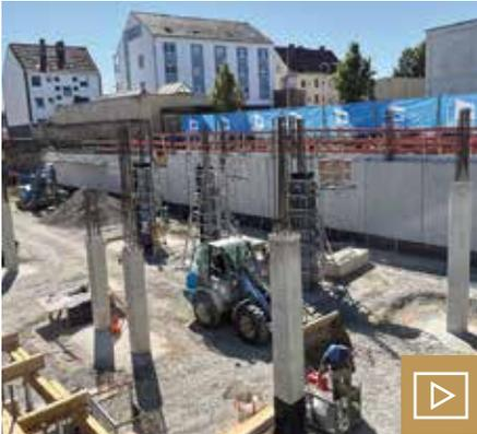
PAX HD Stützenschalung: Damit werden die Stützen ohne Vormontage, kranunabhängig und zügig realisiert werden. Bilder: Mayer
