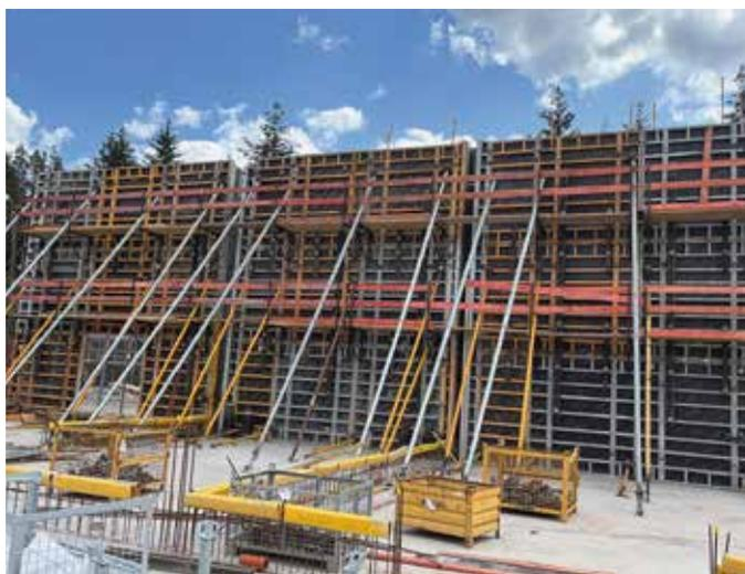
Insgesamt 11.000 m<sup>2</sup> der Rahmenschalung ORMA kommen zum Einsatz. Das ULMA-System ist für hohe Frischbetondrucke konzipiert.
