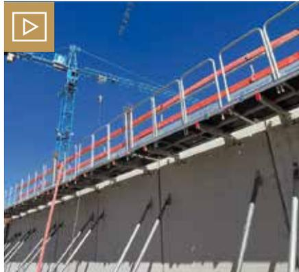
Die sigeMAX Betonierbühne lässt sich mit wenig Aufwand installieren und sorgt für breite und stabile Arbeitsflächen.
