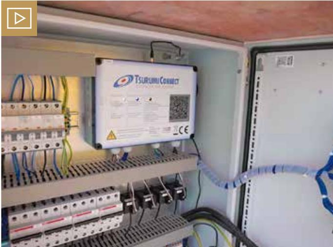
Tsurumi-Connect: Die Elektronikbox im Schaltschrank überwacht und steuert mehrere Pumpen oder weitere Geräte auch anderer Hersteller.
