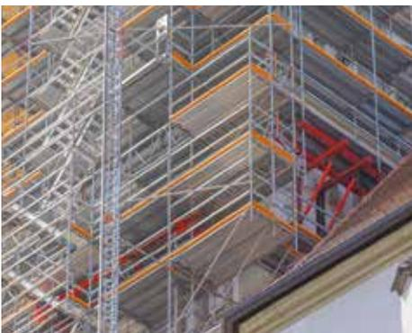
Da eine Lastabtragung über die Dachkehlen bauwerksbedingt nicht möglich ist, musste oberhalb der geneigten Dachflächen eine Konsolbühne realisiert werden.
