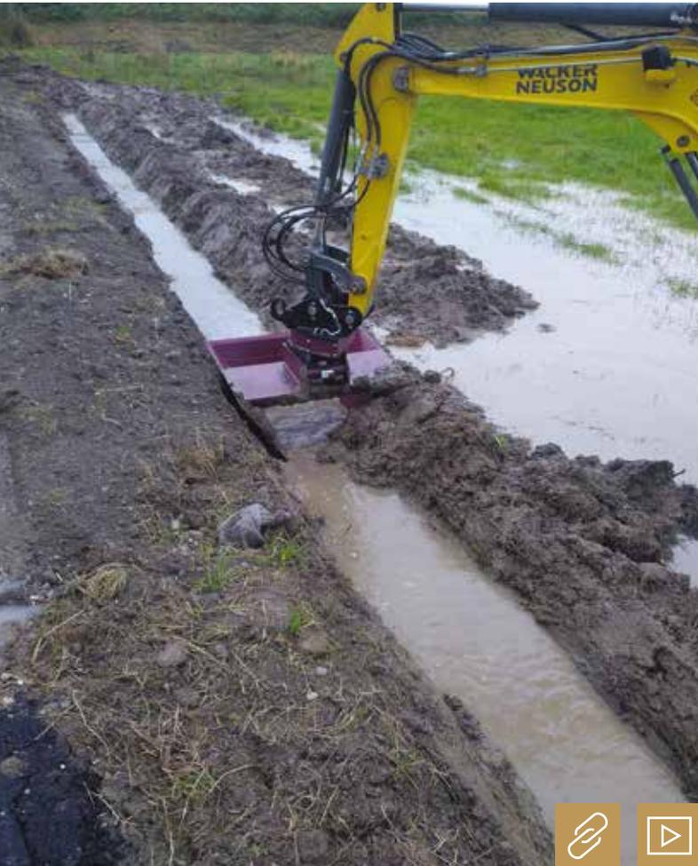
Aktiver Hochwasserschutz mit dem VarioLöffel und RotoTop – mit diesem Zeitspar-Duo werden Gräben schnell und effizient angelegt und gepflegt. Bild: Holp
