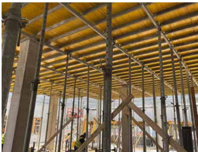
Vor allem die Möglichkeit zum schnellen Ausschalen überzeugt bei dem Einsatz von 6.000 m<sup>2</sup> der Deckenschalung ONADEK. **Bilder: Ulma**
