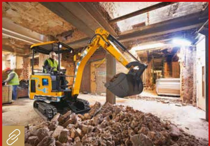
Durch seine Emissionsfreiheit, den besonders leisen Betrieb und seine Kompaktheit ist der Elektrobagger 19C-1E auch für Arbeiten in Gebäuden geeignet. Bild: JCB
