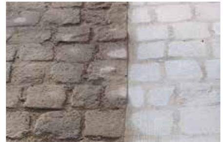
Eben, leise und barrierefrei: Links der ursprüngliche Untergrund, rechts nach Fugenverfüllung und Schneidarbeiten.
