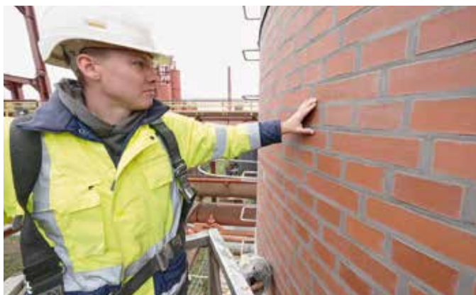
Georg Mende, Juniorchef und Bauleiter der Mende Schornsteinbau GmbH & Co. KG, kontrolliert das Fugenbild am Schornstein S4.
