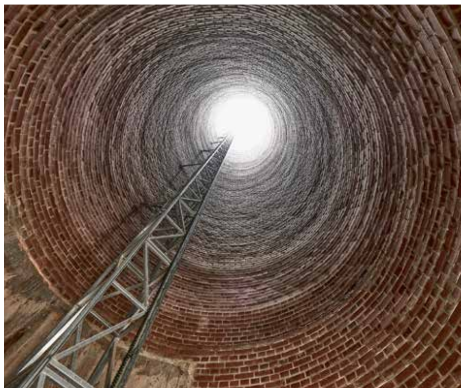
Ein herkömmlicher Materialaufzug wurde so umkonstruiert, dass die Mauerteams auf der Plattform nach oben fahren und auch mauern können. Bilder: Ingo Jensen / quick-mix
