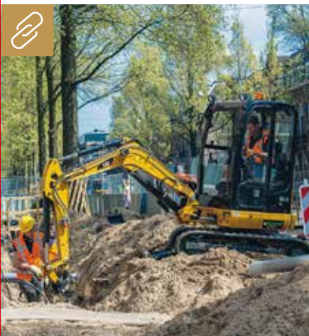
Eine der neuesten klimafreundlichen Cat-Maschinen ist der 302.7 Dual Power, der zusätzlich zum Dieselantrieb noch über einen Elektroantrieb verfügt. Bild: Zeppelin
