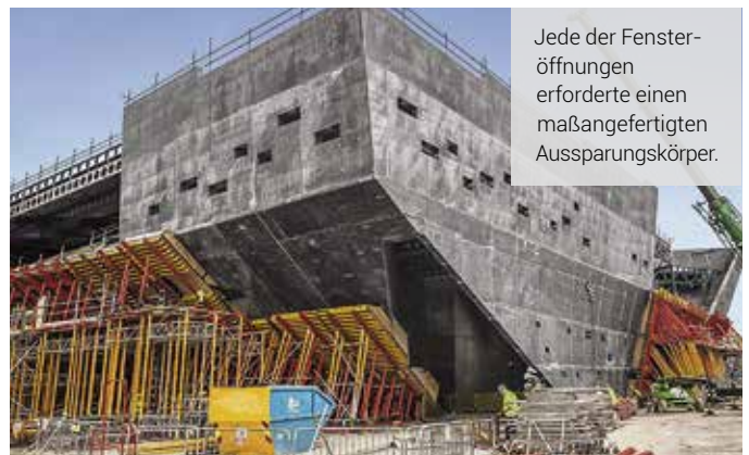
Die äußere Schalung und das Traggerüst verblieben in Position, bis das Dach errichtet war.
