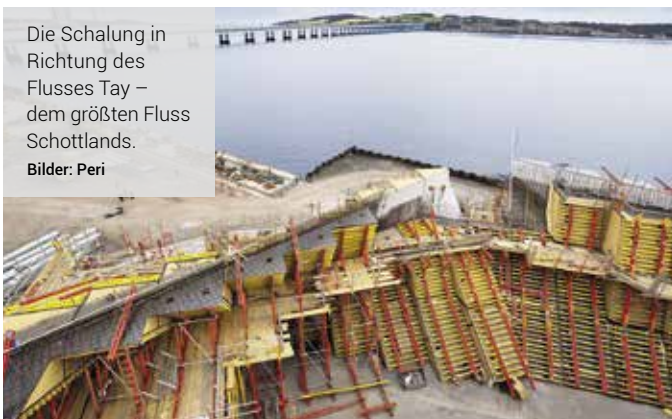
Bis zu 1.000 m 2 maßangefertigter Schalungselemente wurden pro Monat von Peri ausgeliefert.
