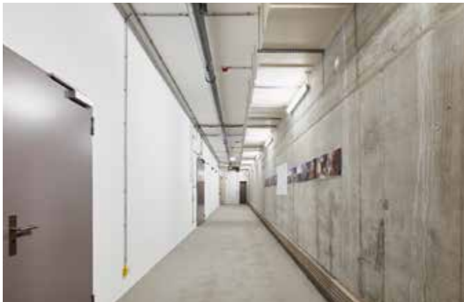
Die Wände der Depoträume wurden nichttragend mit mittelformatigen KS-Plansteinen von KS-Original errichtet Bilder: Palladium.de/KS-Original
