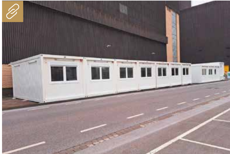
11 Einzelcontainer von Weisig bilden einen Bürogebäudekomplex mit allen notwendigen Funktionsräumen. Bild: Weisig Maschinenbau
