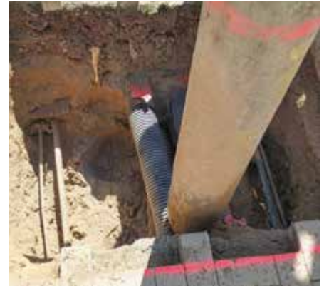
Saugen statt Baggern schont die freizulegende Infrastruktur.
