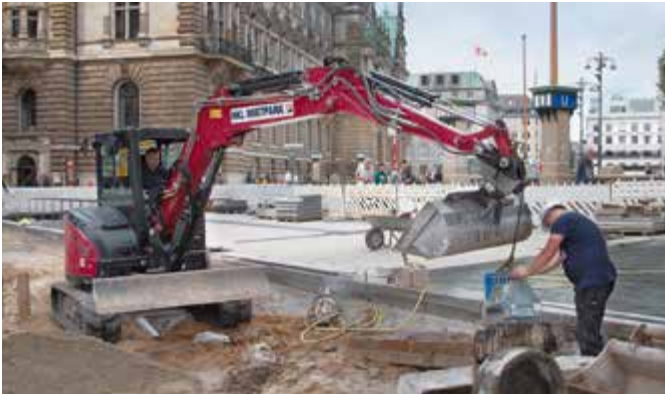
Ein HKL Kurzheckbagger mit angebautem Vakuumsauger wird u. a. für das Ausheben und Einsetzen der Bordsteinkanten genutzt.
