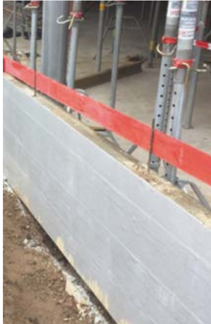
Die Lösung dichtet an Stoß- und Nahtstellen der Folie sowie an Übergängen von Sockeln und Fundamenten optimal ab.
