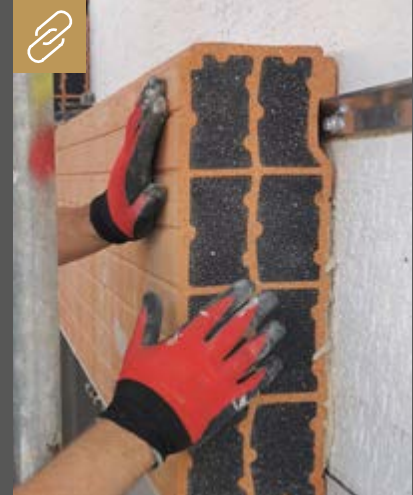
Das neue diffusionsoffene ZMK-Fassadenelement hat eine Stärke von 175 mm und ist eine optimale Lösung bei Bestandsgebäuden. Bild: Kellerer
