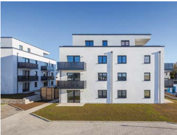
Alle drei Mehrfamilienhäuser sind CO 2 -neutral gebaut – dank ökologischer Baustoffe, Erdwärme und Photovoltaik-Anlage auf dem Dach.
