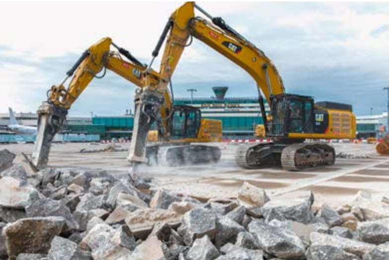
In fünf Abschnitten werden die Rollfelder des Flughafens seit 2021 saniert. Dazu wird die Bestandsfläche von insgesamt 110.000 m 2 abgebrochen und neu aufgebaut – auch mit Zeppelin-Mietmaschinen.
