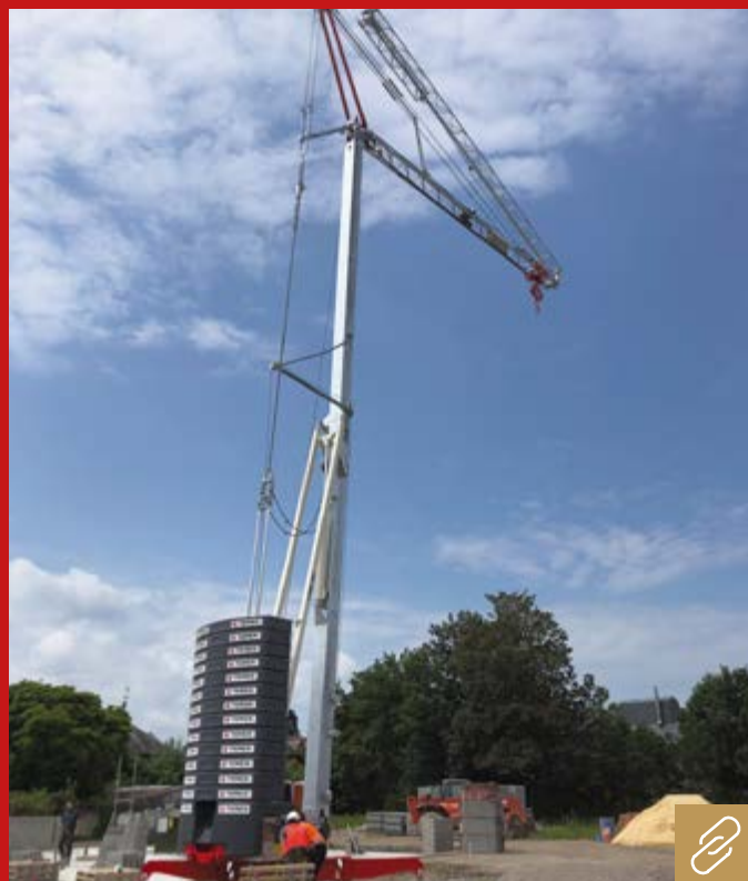
Das Steuerungssystem Easy Setup für den Aufbau der CSE-Krane von Terex ermöglicht eine exaktere Einrichtung und eine deutlich verkürzte Rüstzeit vor Ort. Bild: Terex
