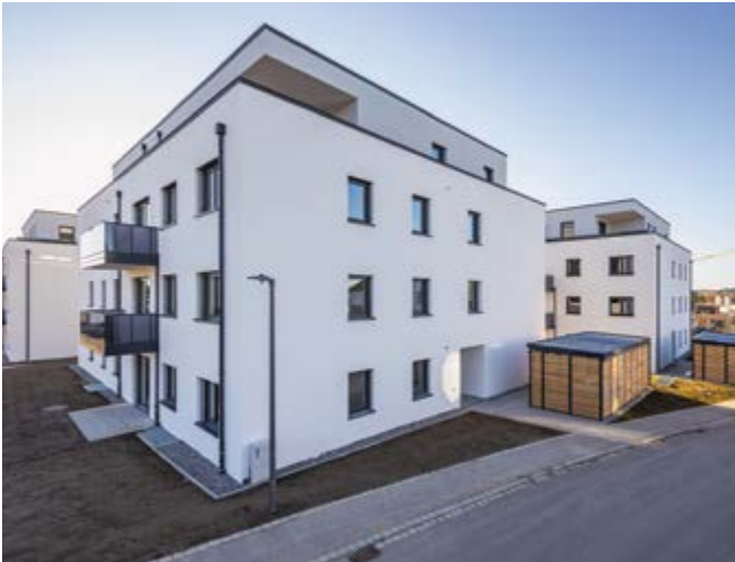
Für die Gebäudehülle hat Leipfinger-Bader die hochwärmedämmenden WS09 Silvacor Mauerziegel in der Stärke 36,5 cm geliefert.
