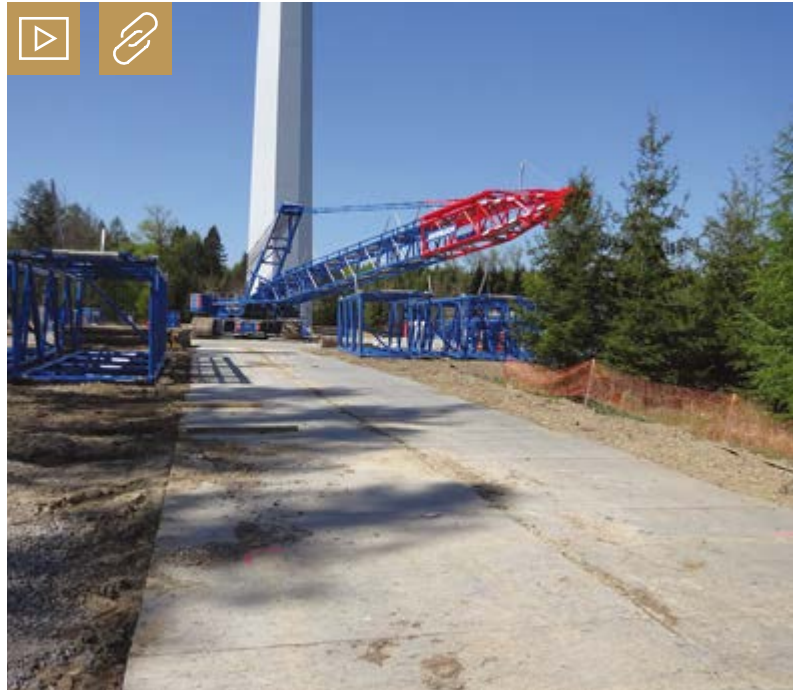
Um den Boden befahrbar zu machen und ihn vor der Verdichtung durch Baufahrzeuge und Lkw zu schützen, kommen bei der Errichtung von Windkraftanlagen mobile Straßen zum Einsatz. Bild: Vp TPA
