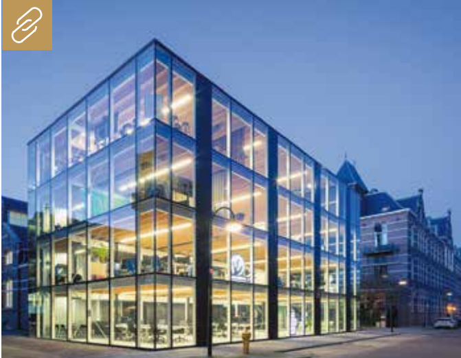
In Delft ist mit dem Projekt „D(emountable)“ ein vollständig zerlegbares Gebäude entstanden. Bild: Cepezed / Lucas van der Wee
