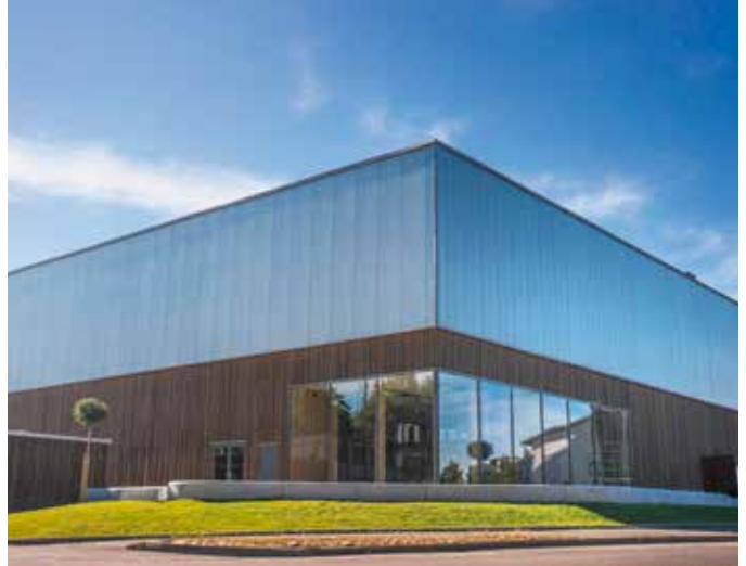
In Schweden wurde eine temporäre Markthalle komplett saniert und in eine Sporthalle umgewandelt. Bild: Metsä Wood
