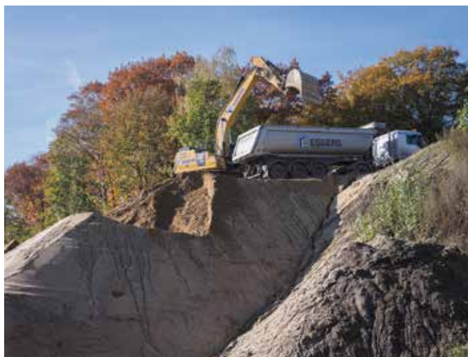
Massenbewegung im großen Stil: Jeweils 150.000 t Schottertrag- und Frostschutzschicht müssen von Eggers aufgebracht werden. Darüber hinaus sind 430.000 t Sand zu liefern und einzubauen. Zudem hat das Team 585.000 m 3 Boden abzutragen. Bild: Sebastian Engels
