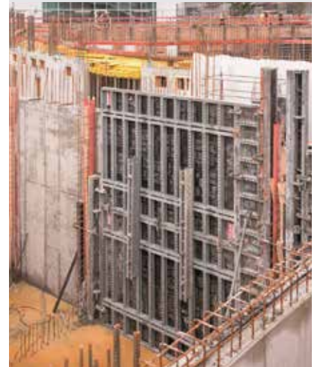
Die Errichtung von sehr hohen Wänden gehörte zu den kleineren Herausforderungen, die das Objekt für das Baustellenteam bereit hielt. Bilder: Noe
