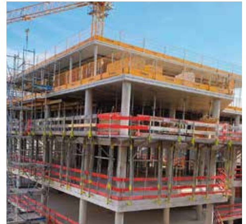
Die Absturzsicherung MBP kommt in den oberen Etagen zum Einsatz und sorgt für hohe Sicherheit an den Deckenrändern.
