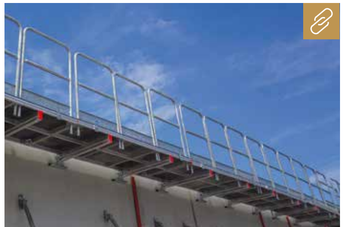
Mit der Betonierbühne sigeMAX lässt es sich komfortabel und sicher arbeiten – dank einer breiten und stabilen Arbeitsfläche. Bild: Mayer
