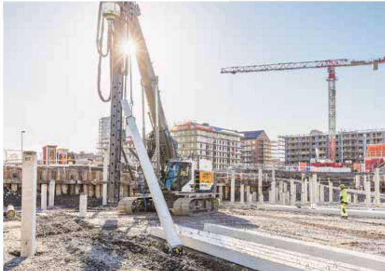
Das Gerät zeichnet sich u. a. durch einen großen Arbeitsbereich aus. Eine Ausladung bis zu 8,7 m hat den Vorteil, dass die Maschine beim Arbeiten nicht ständig umgesetzt werden muss.
