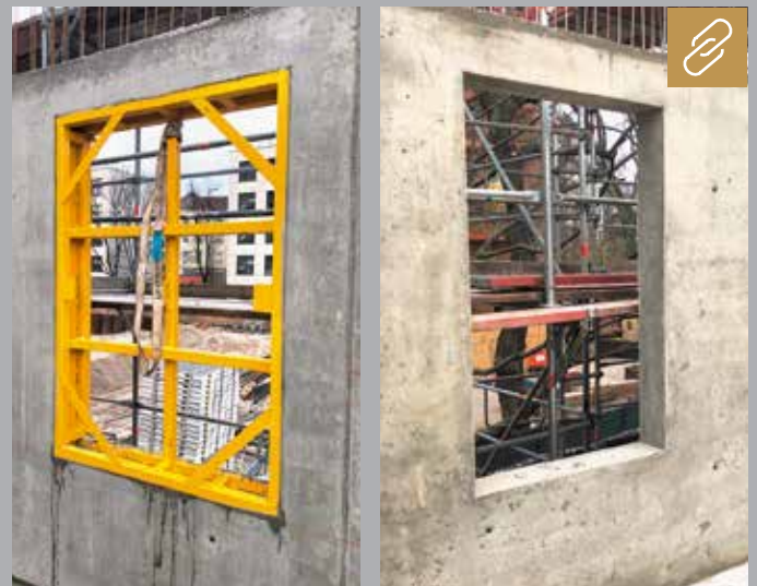
Beim Bauvorhaben „Hallesches Ufer“ in Berlin werden nachhaltige, weil wiedergewinnbare Schalkörper aus Stahl eingesetzt. Bild: Robusta-Gaukel
