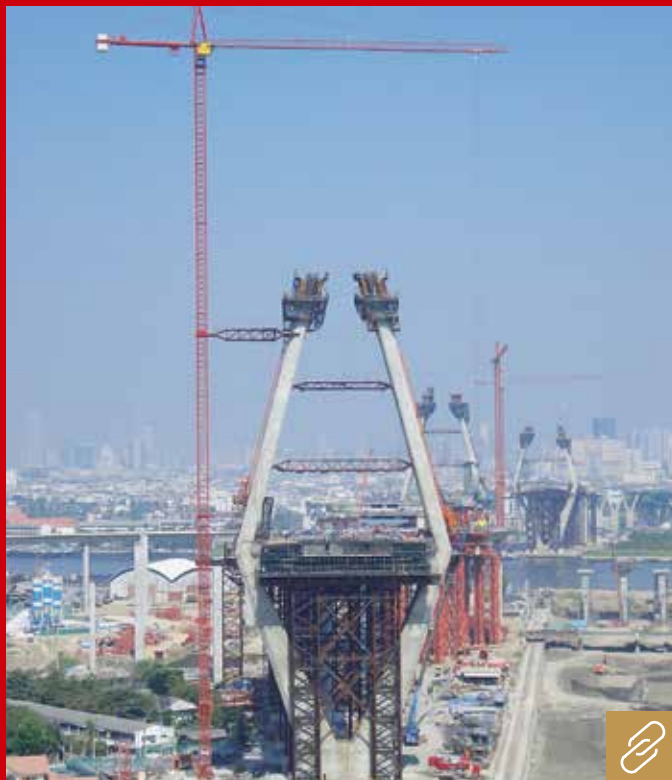
In 175 m Höhe schwebt die Hakenflasche dieses Krøll K-320 über dem Boden Thailands; der am Brückenpfeiler verankerte Kran erzielt 75 m Ausladung, 18 t maximale Traglast und 3,2 t Last an der Spitze. Bild: Krøll
