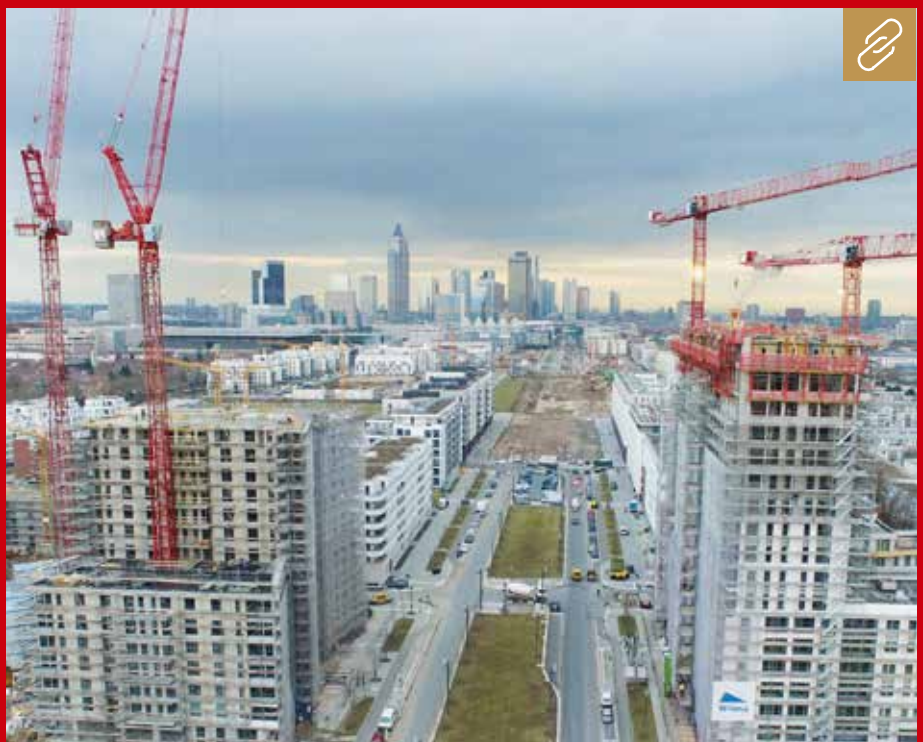
Friedlich stehen sich zwei Wippkrane WT335L e.tronic und zwei Katzkrane WT420 e.tronic von Wilbert in Frankfurt gegenüber; die einen können dicht aneinander vorbeischnellen, die anderen sich knapp überschwenken. Bild unten: Wilbert
