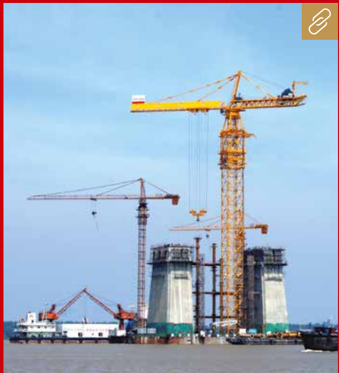
Kaum bekannt sind auf deutschen Baustellen chinesische Turmdrehkrane, doch trumpfen die wie dieser Zoomlion D-5200 für 208 m Hakenhöhe und 240 t (!) maximale Traglast mit Höchstleistungen auf. Bild: Zoomlion
