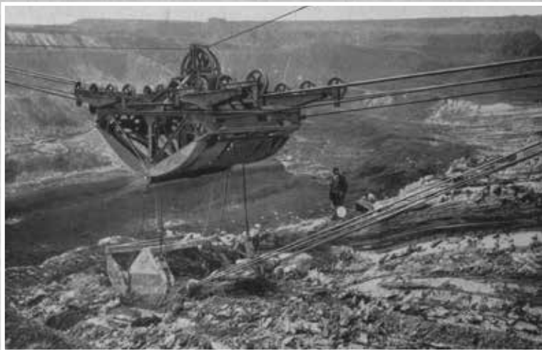
Der neben dem 8-m 3 -Schürfkübel klein wirkende Arbeiter hielt eine große Signalkelle, um dem Maschinenführer die Schürfstrecke anzeigen zu können.
