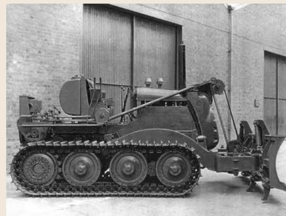
Schön zu erkennen ist der nicht am Heck, sondern in der Mitte hoch angeordnete Fahrerstand der Vickers-Raupe und die abfallende Motorhaube für optimale Sicht.
